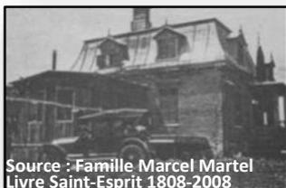
Toiture à mansarde à quatre versants cintrés en tôle à baguette. La toiture de la galerie est faite de tôles pincées.
