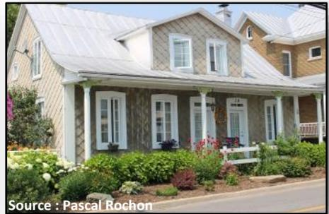
extérieur singulier. Il s'agit de bardeau d'amiante-ciment unique en son genre et dans la région. Ce composite d'amiante et de ciment Portland est apparu au début du 20<sup>e</sup> siècle. Les colonnes et les consoles sont d'origine.
