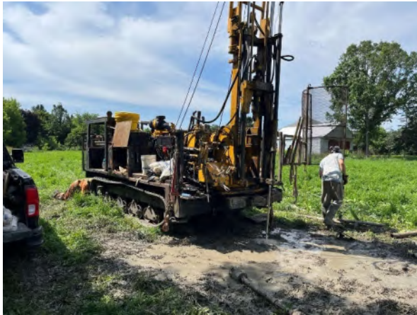
Vue du forage 23F1
