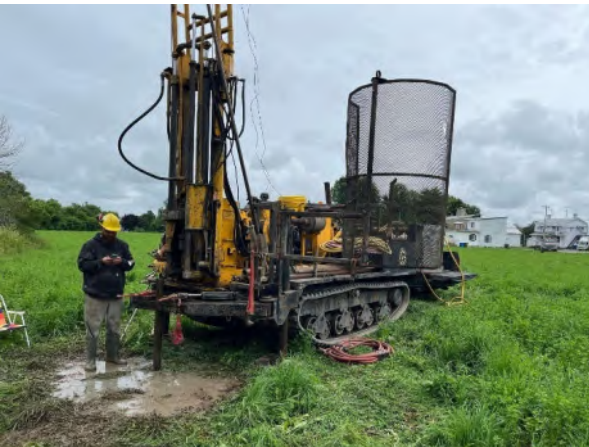
Vue du forage 23F3
