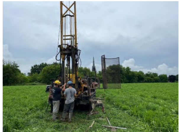
Vue du forage 23F4
