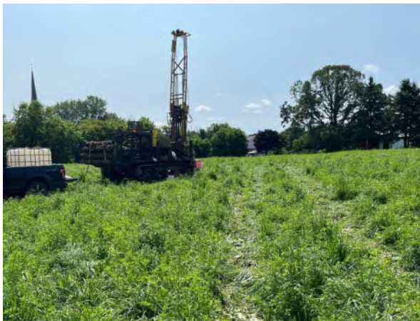
Vue du forage 23F5
