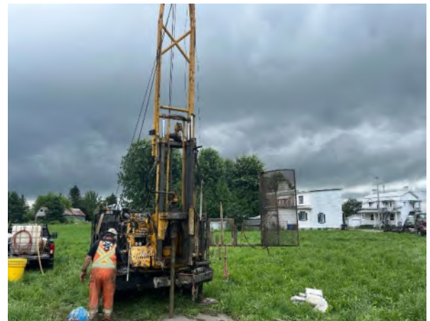
Vue du forage 23F6
