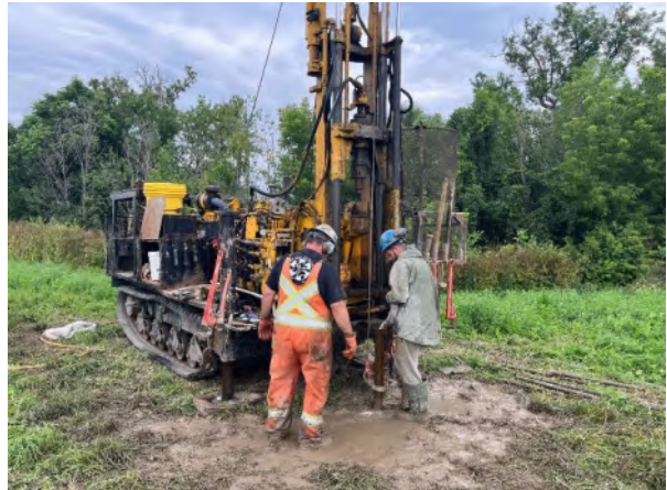
Vue du forage 23F2
