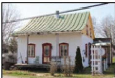
**La toiture à croupe** Ce modèle de toiture exige une charpente plus complexe, la croupe représentant chacune des extrémités d'une toiture à deux versants auxquelles on donne une pente vers l'intérieur, ainsi la toiture présente quatre versants, les longs pans des façades et les petits versants des extrémités.
